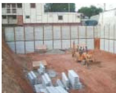
**Foto 7** – A concretagem de todo o perímetro se faz pelo vão da laje superior
