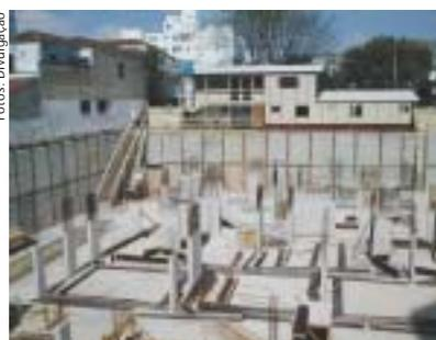
**Foto 1** – Escavados os subsolos, o edifício é construído como uma caixa
