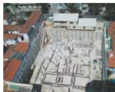
**Foto 8** – As cortinas são travadas com as lajes do subsolo e do térreo
